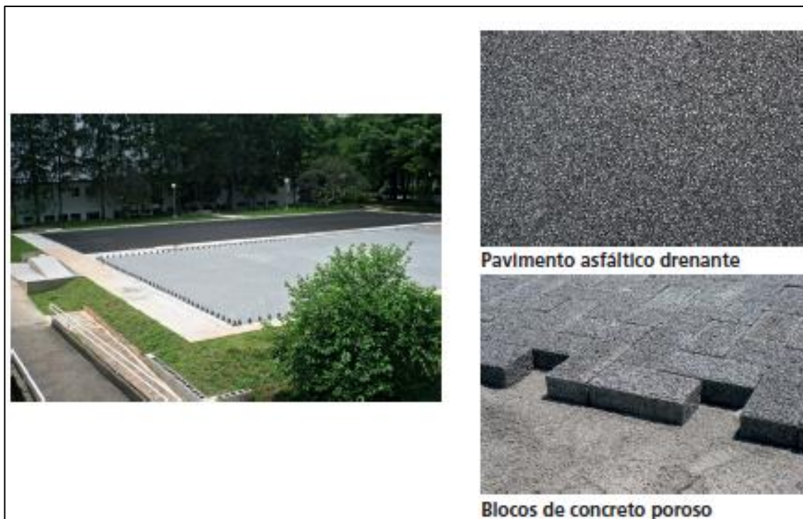
Figura 1.5 – Exemplo de pavimentos permeáveis e porosos
