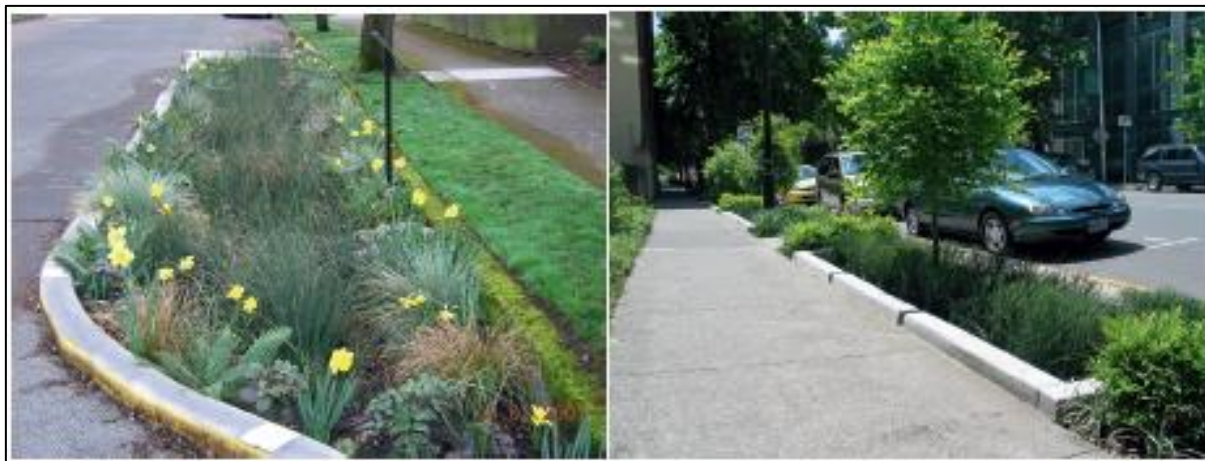
Figura 1.8 – Exemplo de valas de infiltração
