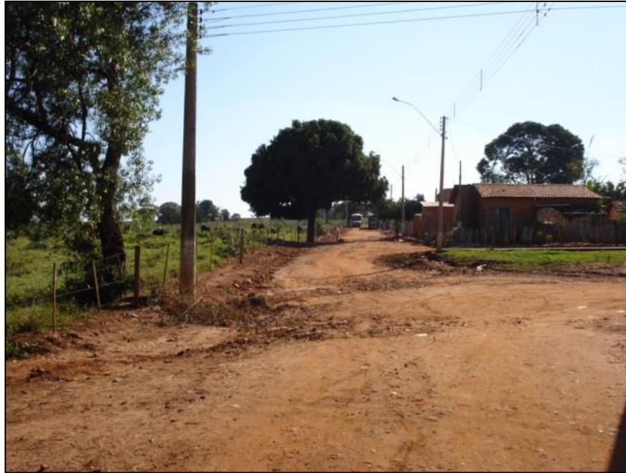
Figura 8.3 – Inexistência de sistema de drenagem urbana
